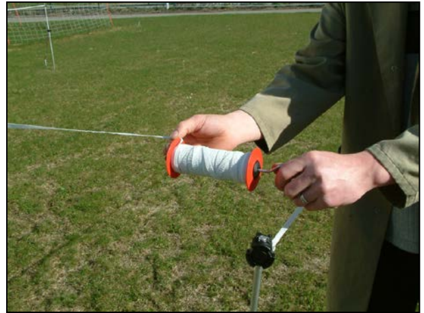
6.) Bandlänge zum Einhängen des Griffes ermitteln
