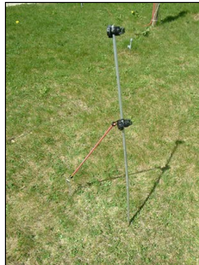
2.) Pfähle in Erde stecken und diagonal nach außen abspannen
